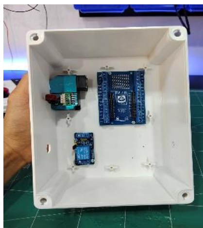
รูปภาพที่2. ติดตั้งอุปกรณ์ภายในกล่องอุปกรณ์
